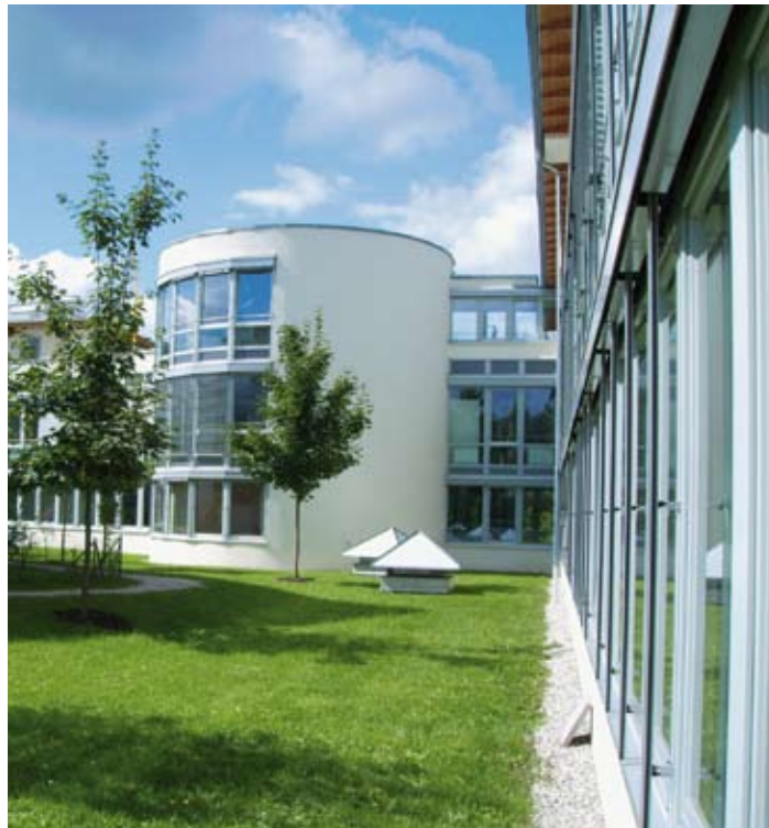
82319 Starnberg, Buchhofstrasse / Kreuzstrasse
