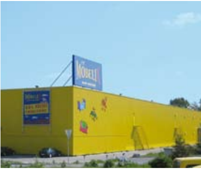
2103 Langenzersdorf, Wiener Str. 210-218
