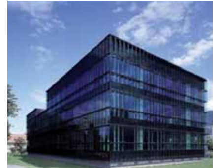
6850 Dornbirn Rechenzentrum / Schmelzhüttenstraße 26
